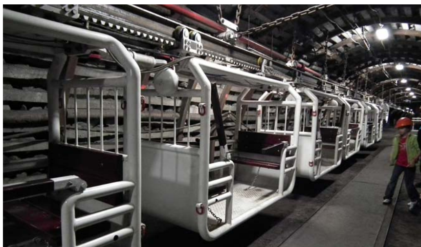
Rys. 8. Podwieszana kolejka elektryczna dostosowana do osób niepełnosprawnych, Kopalnia Guido [fot. autorka].
