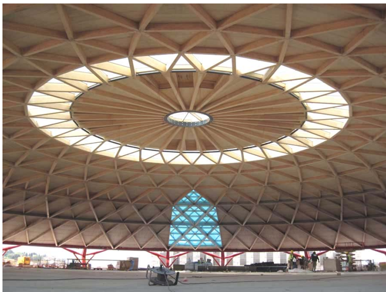
Rys. 1. Struktura powłoki siatki dachu. Centrum handlowe Las Arenas, Barcelona. Struktura powłoki siatki dachu osiąga 60 min. odporności ogniowej według Eurokodu [7].
