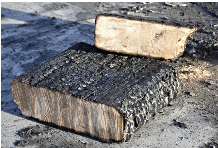
Rys. 4. Elementy z drewna klejonego poddane działaniu pożaru – przekrój [1].
