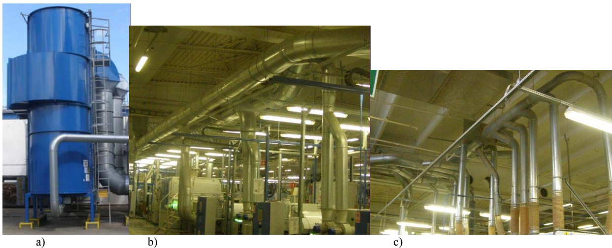
Rys. 6. Elementy instalacji wyciągowej linii szlifierek z lakiernią: a) - komora filtra; b) - wyciąg główny; c) - wyciągi pomocnicze.
